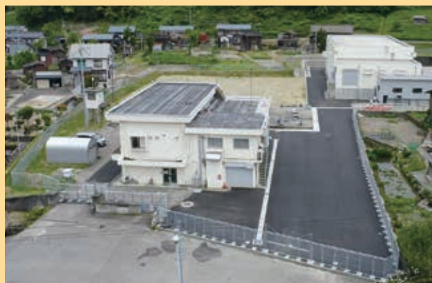
▲栃尾浄水場更新工事（栃堀地内）
