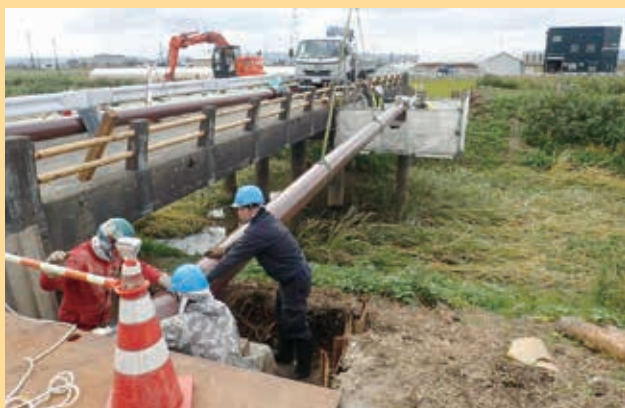
▲耐震管布設工事（鉢伏町地内）
