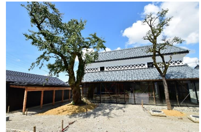
▲整備が完了した「米蔵」
