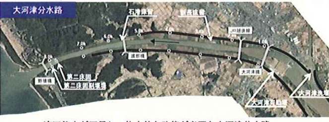
流下能力が不足し、抜本的な改修が必要な大河津分水路
