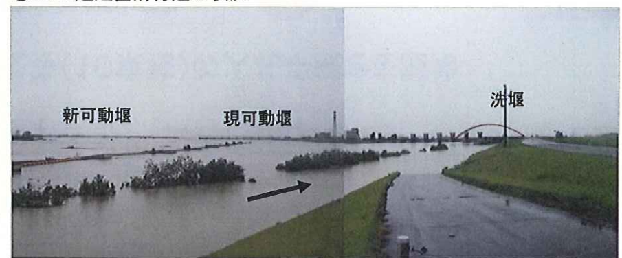
②HWL超過箇所付近の状況
