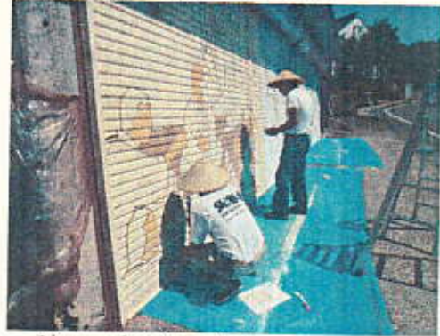
連日、炎天下の作業
