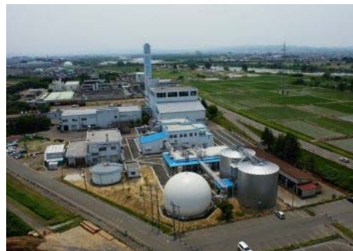
生ごみバイオガス発電センター
