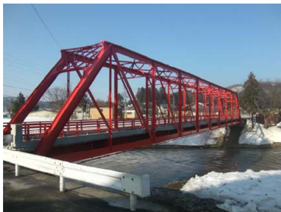
長岡の橋梁の長寿命化の推進 (リニューアルした不動沢橋)
