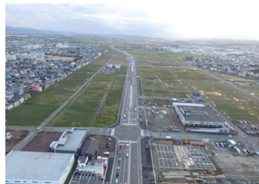
左岸バイパスの4車線化
