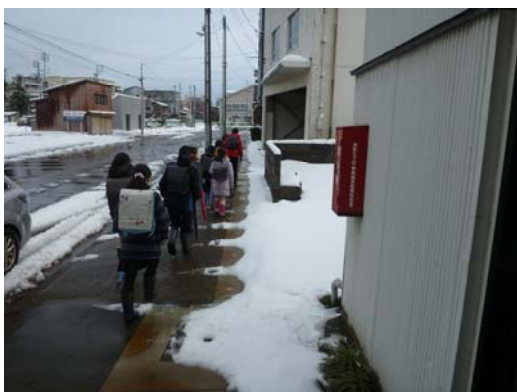
消雪パイプ整備による安全な通学環境
