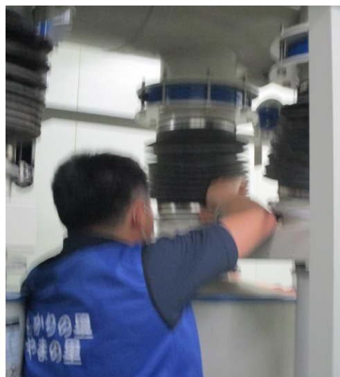
フィルタリングシステムの起動
