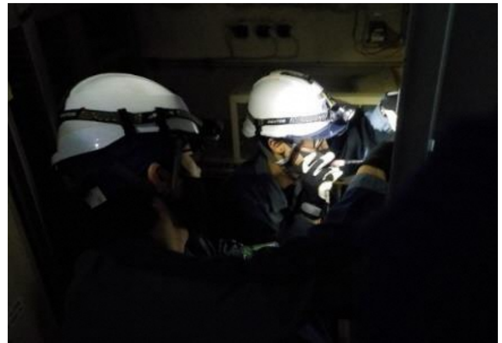
電源喪失を想定した現場訓練
