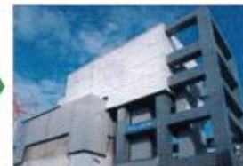
2013年11月12日カバー工事完了
