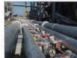
工事が完了した山側の状況
