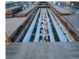
工事が完了した海側の状況
