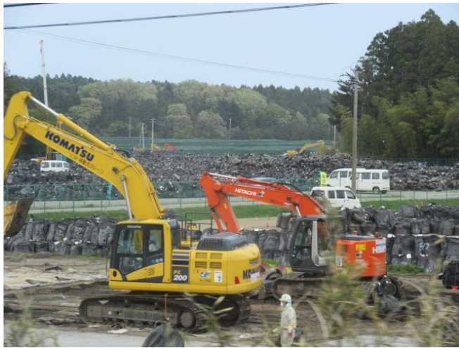
進む除染作業
