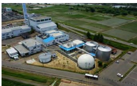
生ごみバイオガス発電センター
