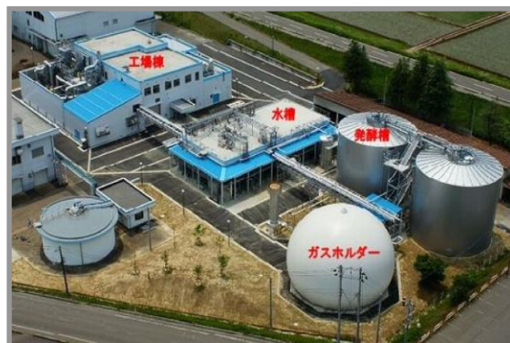
生ごみバイオガス発電センター
