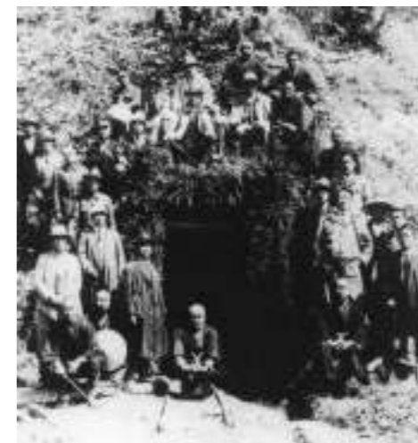
▲中山隧道落成記念写真(個人所蔵) 昭和8年(1933)に始まった住民たちの手掘り隧道工事は、昭和24年に貫通。その苦闘のあゆみは映画「掘るまいか」で紹介され、平成18年度には土木学会選奨土木遺産に認定された。
