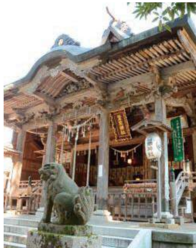
▲蒼柴神社拝殿(長岡市悠久町) 第3代長岡藩主牧野忠辰を祀るために、牧野忠精により造営された。国登録有形文化財。
