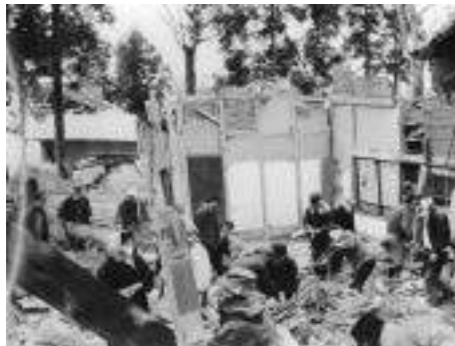
▲長岡地震で全壊した家屋
