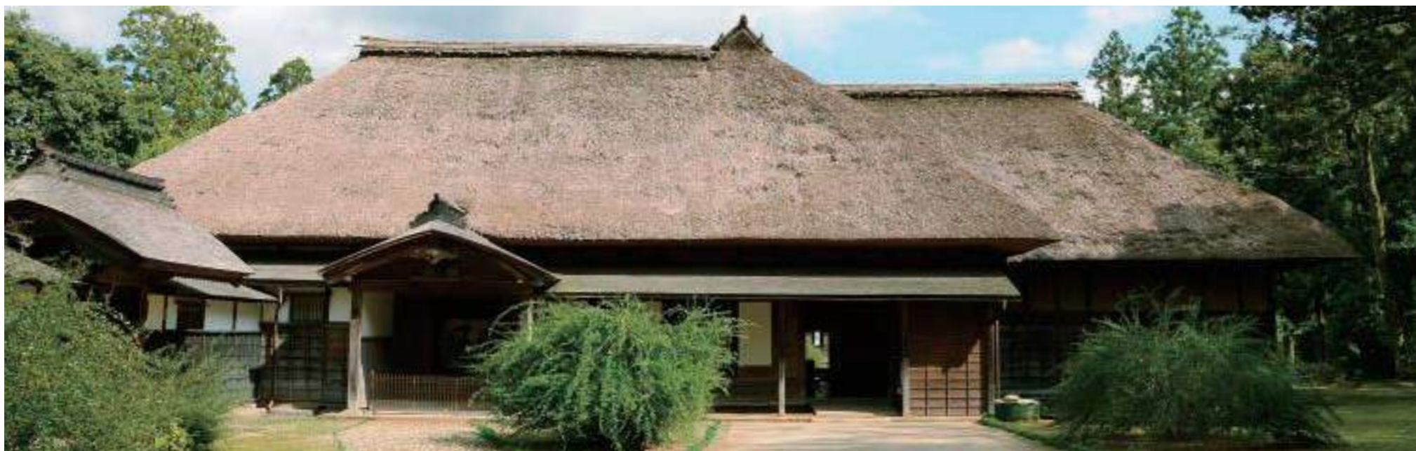
▲旧長谷川家住宅（長岡市塚野山） 塚野山庄屋長谷川家は、幕府領、上山藩領など領主が変わるなか、周辺村々の責任者として指導力を発揮した。住宅の主屋は、享保元年（1716）再建とされる県内に現存する最古の住宅建築。国指定重要文化財。
