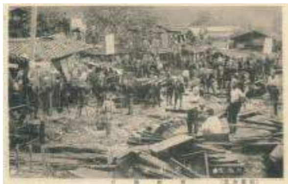
▲栃尾大水害（柏崎市立図書館所蔵） 大正15年（1926）7月に発生した大水害。大雨による刈谷田川の氾濫などで、死者・行方不明者87人の人的被害があった。
