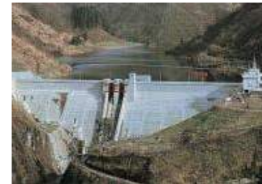
▲刈谷田川ダム完成 昭和55年(1980)、流域を度重なる水害が襲った刈谷田川上流にダムが完成した。
