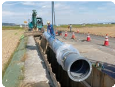
送水管布設工事(三島地域)
