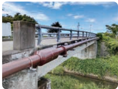
耐震管布設替工事(釜ヶ島地内)
