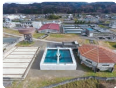
妙見浄水場濃縮槽築造工事(妙見町地内)
