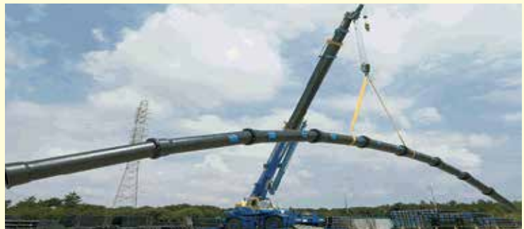
管の継ぎ手を強くした耐震管
