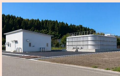
（三島ポンプ場）
