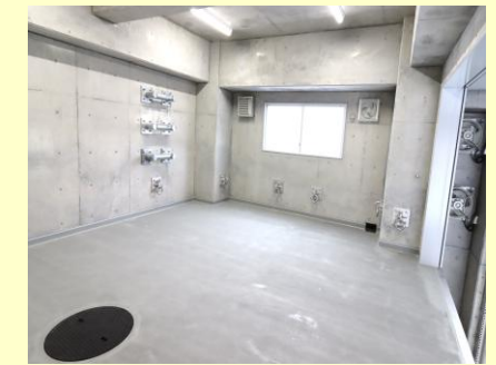
屋内訓練スペース
