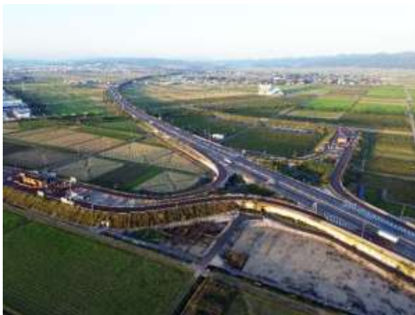
長岡北スマートインターチェンジ
