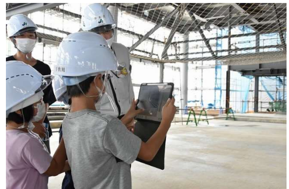
建設中の空間にタブレット端末をかざすとバーチャル映像が出現。その場所の完成後の様子を見ることができました
