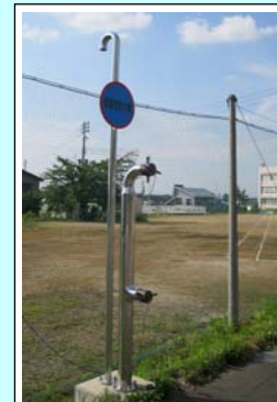
耐震性貯水槽の設置(六日市小学校)
