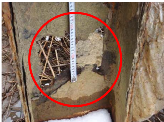
原因：橋脚の腐食による欠損
