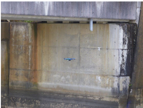
ドローンによる点検
