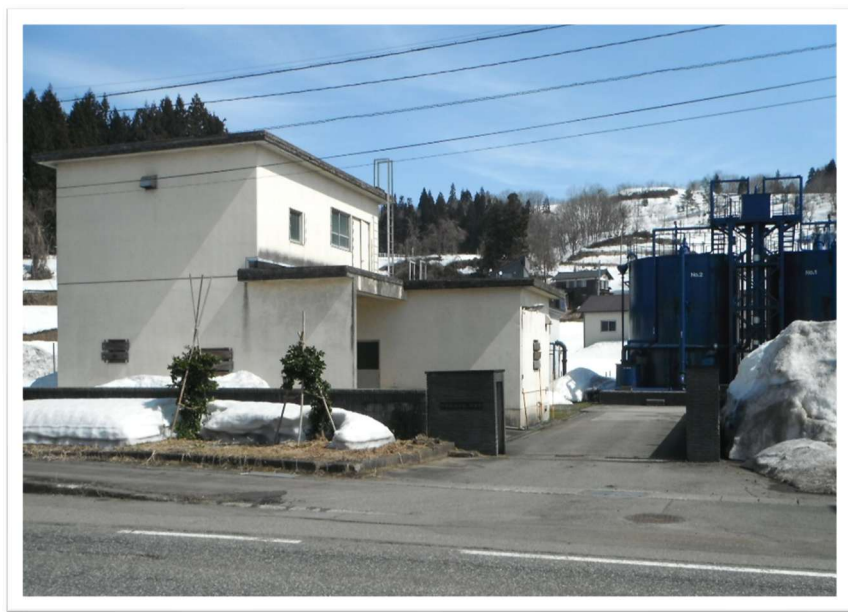
川口中央簡易水道 中山浄水場
