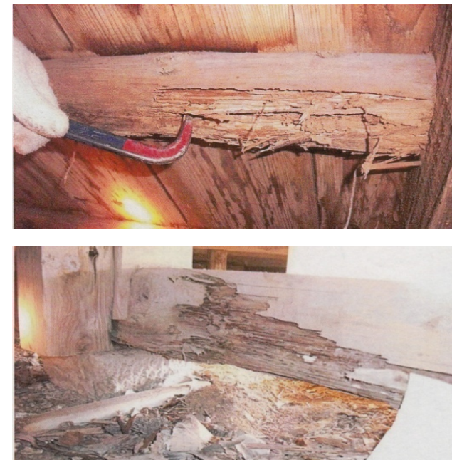
<床下被害状況>
