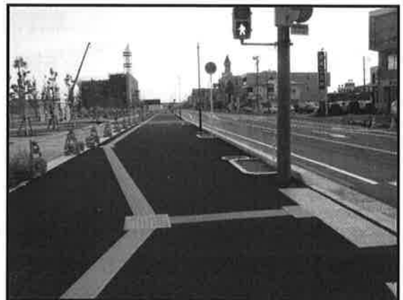
図 15 バリアフリー化された歩道 (長岡防災シビックコア地区)
