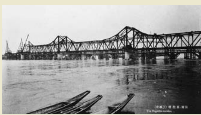
▲工事中の長生橋（昭和12年ころ） 東詰から長生橋を渡る際の道路の曲がりや歩道上から見える橋脚跡に、昭和12年まで使われていた木橋の名残が見られます。
