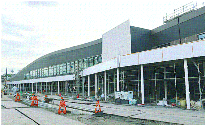
建設中の栃尾地域交流拠点施設「トチオーレ」 ＝長岡市金町1
