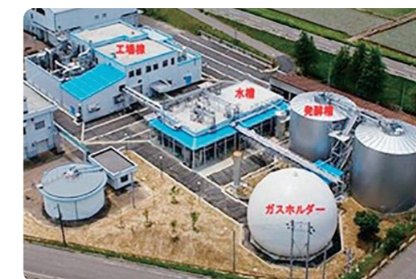
生ごみバイオガス発電センター
