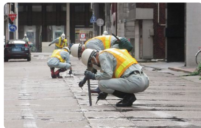
消雪パイプの点検
