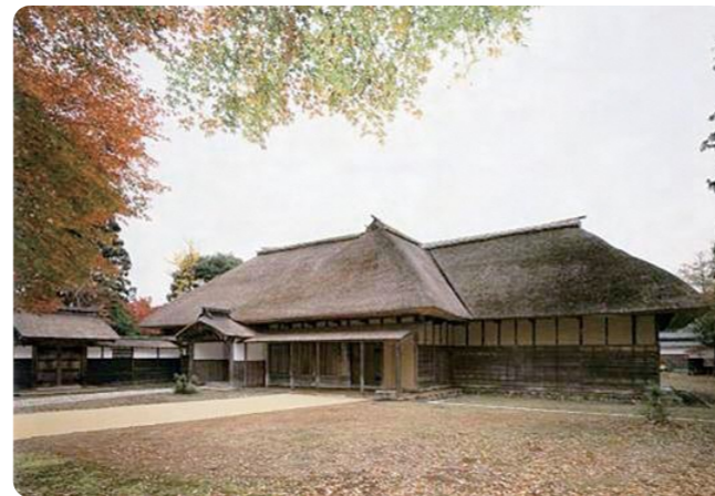
重要文化財「旧長谷川家住宅」
