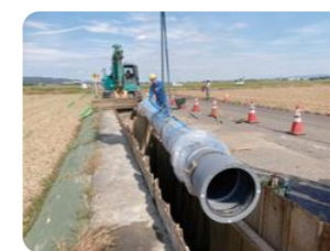
水道管(耐震管)の布設状況
