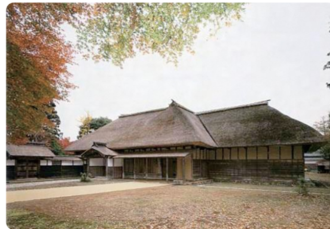
重要文化財「旧長谷川家住宅」
