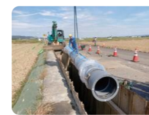
水道管(耐震管)の布設状況
