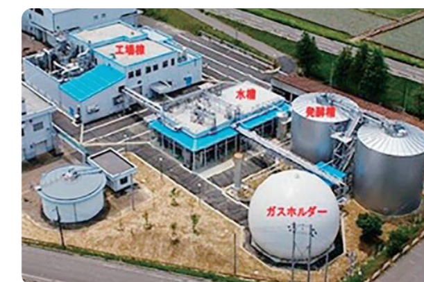
生ごみバイオガス発電センター
