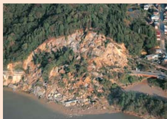
幅250mの大崩落で走行中の車4台が巻き込まれました。
