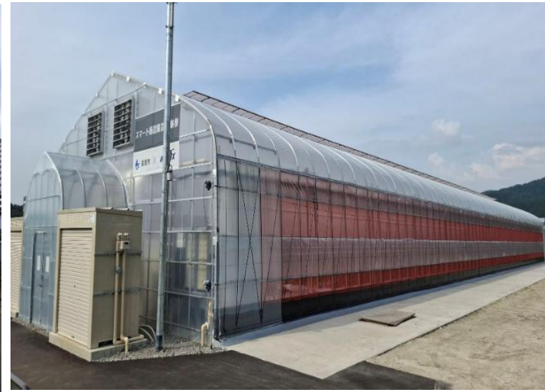
農業体験温室棟 温室3
