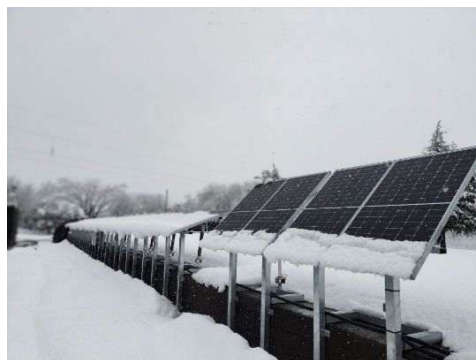
【長岡中央浄化センター】
