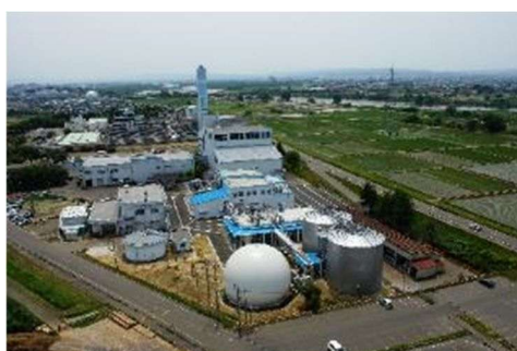
生ごみバイオガス発電センター
