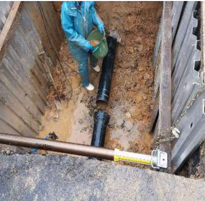
離脱した耐震化されていない水道管（七尾市）
