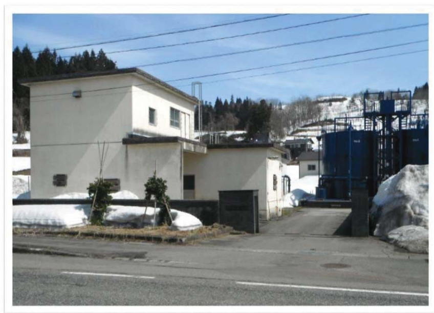
川口中央簡易水道 中山浄水場
