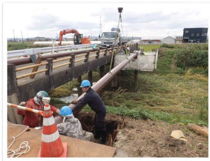
耐震管布設替工事
