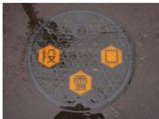
投雪口マンホール
