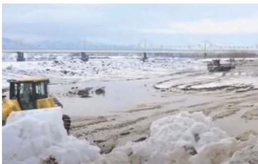
長生橋西詰め下流
