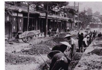
第一期下水道事業（本町 3 丁目）
