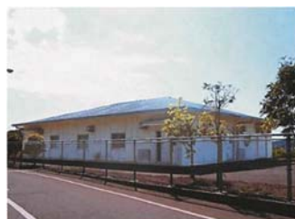
桐原地区集落排水処理場
