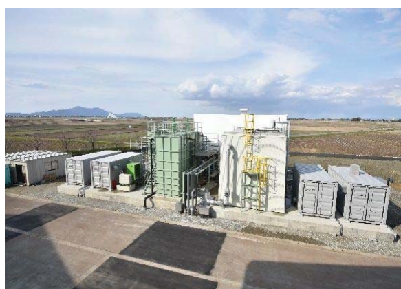
中之島浄化センター 実証研究施設
