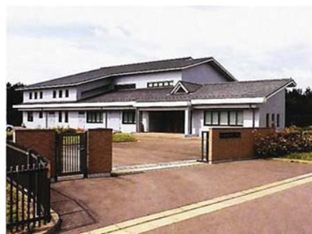
寺泊浄化センター
