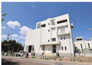
寿町排水ポンプ場
