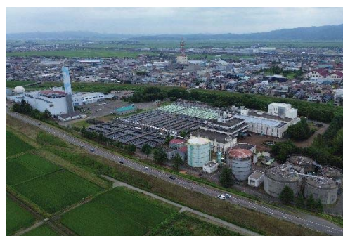
現在の長岡第一下水処理場
