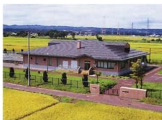
岡南南部浄化センター
