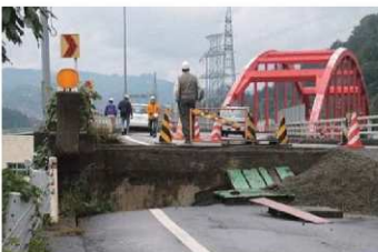
写真1-3 「平成16年新潟県中越地震」により国道117号山辺橋付近の欠陥（小千谷市山本地域）
