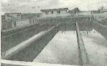
妙見浄水場を視察
