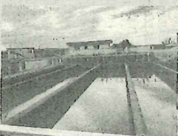
妙見浄水場を視察
