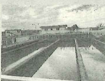
妙見浄水場を視察
