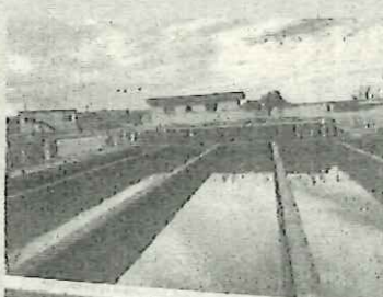
妙見浄水場を視察
