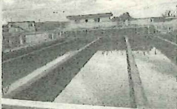
妙見浄水場を視察
