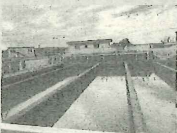
妙見浄水場を視察
