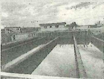
妙見浄水場を視察
