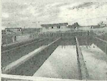
妙見浄水場を視察
