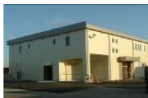
集出荷貯蔵施設
