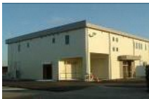
集出荷貯蔵施設
