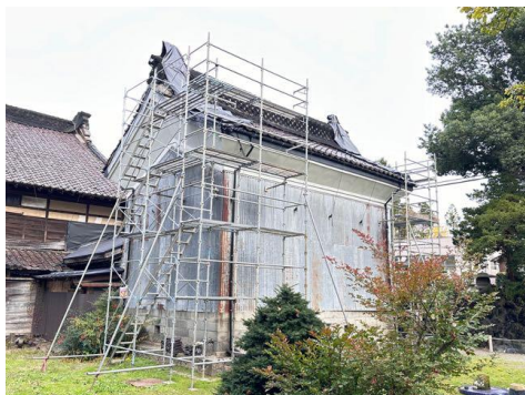
3-01 衣装蔵 南西側外観
