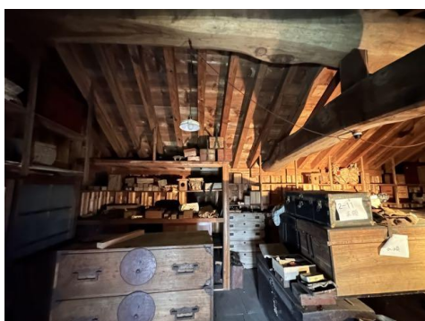
3-21 衣装蔵 内部2階 北から
