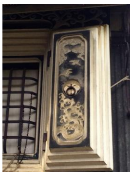
3-07 衣装蔵 東側外観 1階窓
