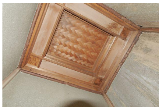
2-36 離れ座敷 内部1階 便所の網代張り折り上げ天井
