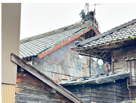
4-05 調整蔵 南側外観
