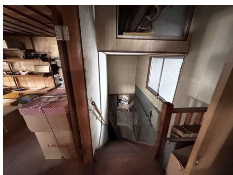
4-19 調整蔵 内部2階 階段室
