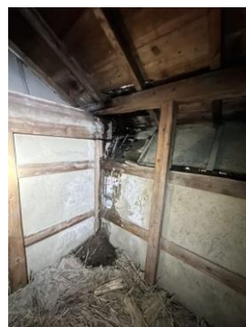
6-16 道具蔵 内部2階 北東端の鉢巻の内側
