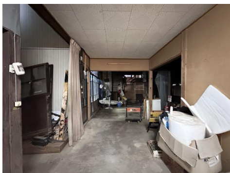
4-07 調整蔵 内部1階 南側廊下接合部
