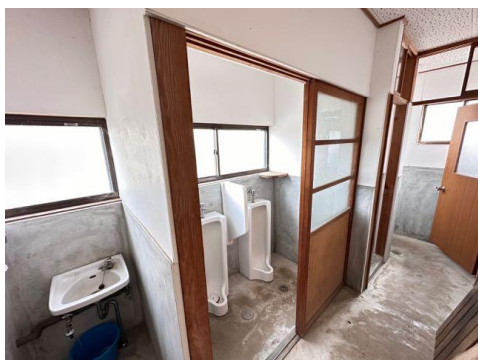
4-09 調整蔵 内部1階 トイレット
