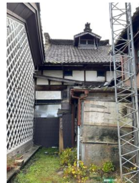
1-06 主屋 外観北側
