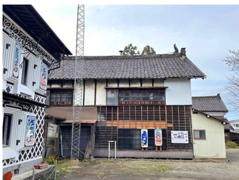
4-03 調整蔵 東側外観
