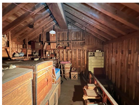
3-20 衣装蔵 内部2階 東から
