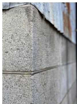
3-10 衣装蔵 基礎石の覆輪目地
