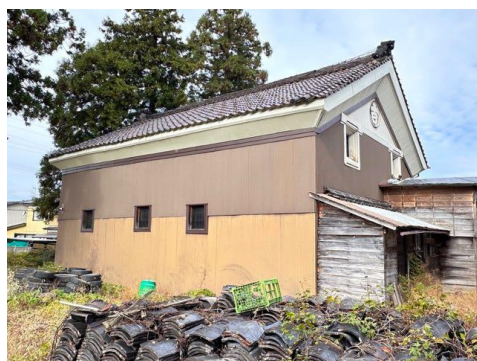
5-06 醸造蔵 南東側外観
