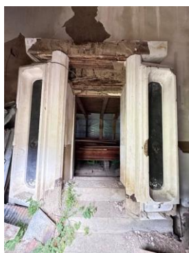
8-07 シチレン蔵 戸前 軸吊り式の観音扉
