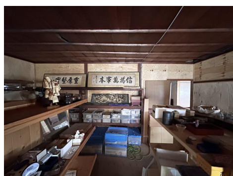
4-24 調整蔵 内部2階 南資材庫 東から
