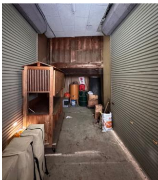
5-15 醸造蔵 内部1階 接続部廊下 東から
