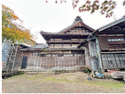
1-02 主屋 外観東側
