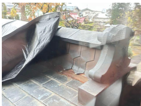
2-13 離れ座敷 玄関唐破風の銅板葺き部分
