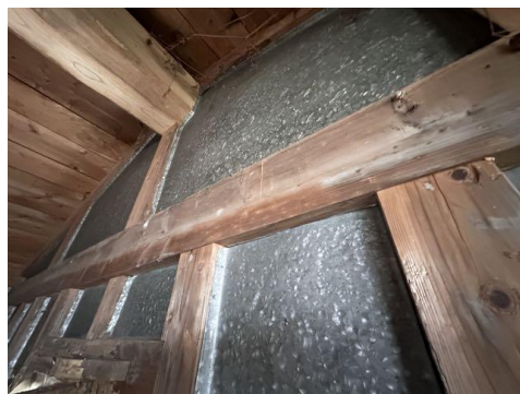
8-18 シチレン蔵 内部2階 東壁
