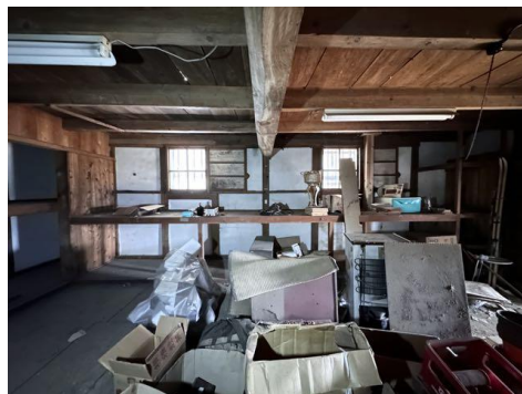
7-10 一号倉 1階内部 北から
