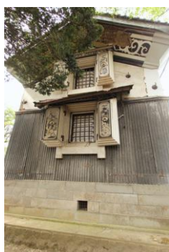
3-05 衣装蔵 東側外観
