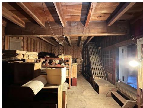
3-13 衣装蔵 内部1階 東から
