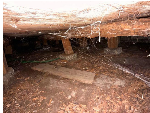
5-10 醸造蔵 内部1階 製品倉庫 床下
