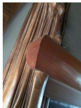
2-28 離れ座敷 内部1階 北和室床脇と長押の雛留め
