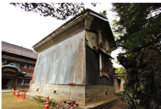
3-04 衣装蔵 南東側外観
