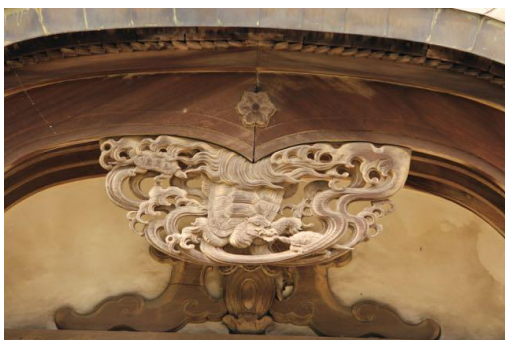
2-07 離れ座敷 玄関破風 兎の毛通し
