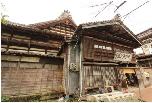
1-01 主屋 外観東側
