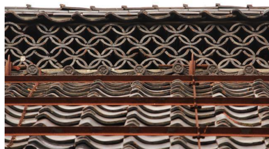
2-12 離れ座敷 主屋根 輪違いの組棟
