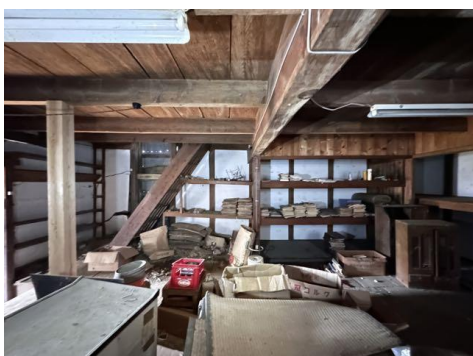
7-11 一号倉 1階内部 南から
