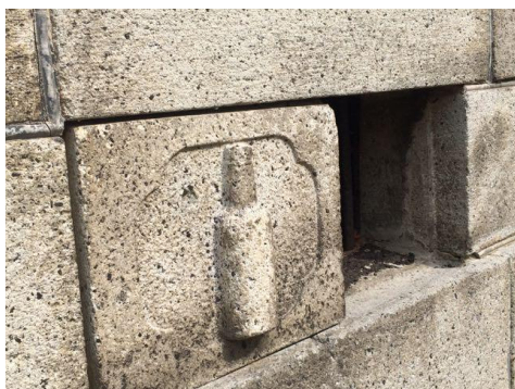
3-09 衣装蔵 床下換気口の蓋
