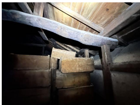
6-15 道具蔵 内部2階 折置組みの梁
