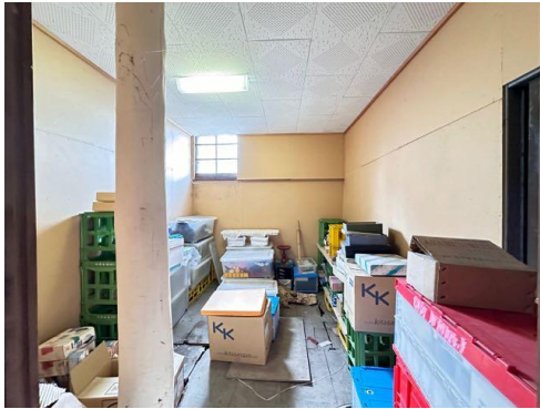
5-09 醸造蔵 内部1階 製品倉庫 北から
