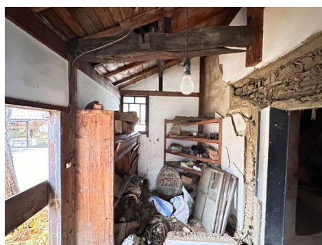
7-06 一号倉 1階内部 戸前 南から
