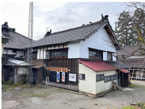
4-01 調整蔵 北東側外観
