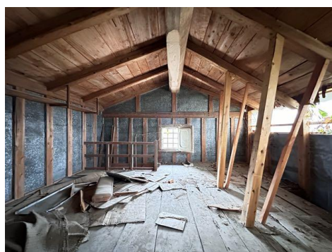
8-16 シチレン蔵 内部2階 西から
