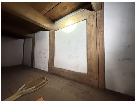
7-15 一号倉 内部2階 東妻壁の窓の痕跡
