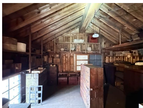
3-22 衣装蔵 内部2階 東から
