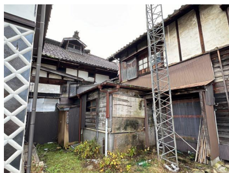
4-04 調整蔵 東側外観
