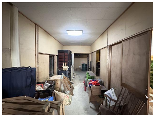
5-16 醸造蔵 内部1階 作業フロア廊下 東から
