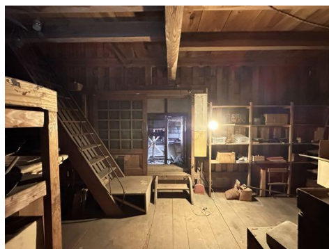
3-14 衣装蔵 内部1階 南から
