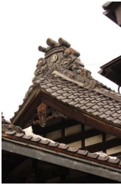
1-03 主屋 外観東側 屋根
