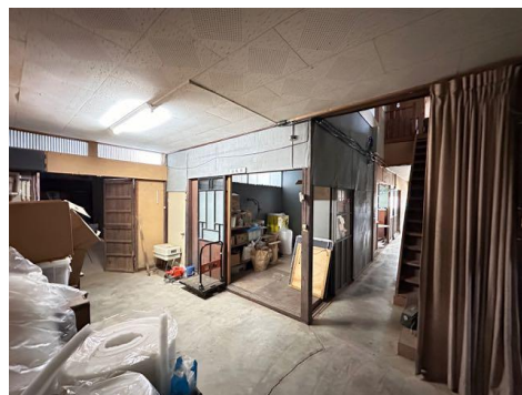
4-18 調整蔵 内部1階 接合部から調整場を見る
