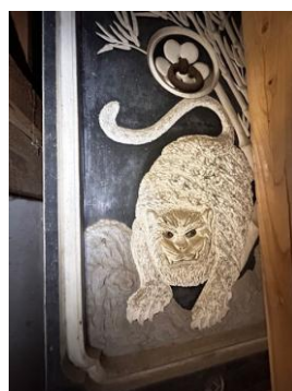
3-12 衣装蔵 北側 出入口戸前 左側女戸扉鍍絵
