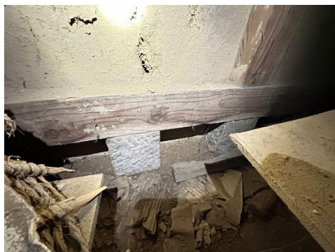
6-09 道具蔵 内部1階 切石基礎と間隙
