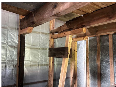
8-13 シチレン蔵 内部1階 南壁の梁補強部分
