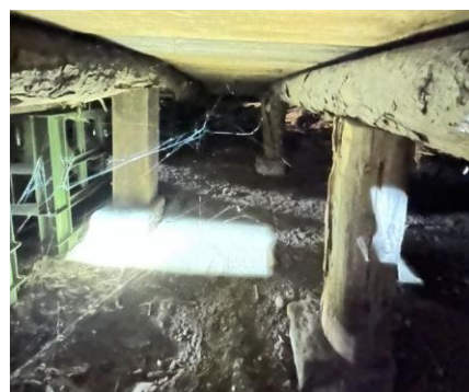
8-14 シチレン蔵 内部1階 床下
