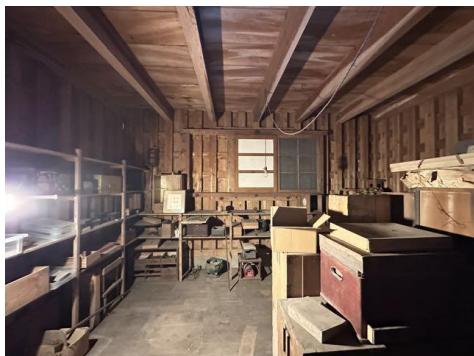
3-17 衣装蔵 内部1階 西から
