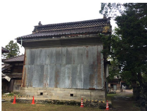
3-03 衣装蔵 南側外観
