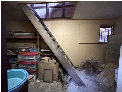
5-11 醸造蔵 内部1階 資材室 南から
