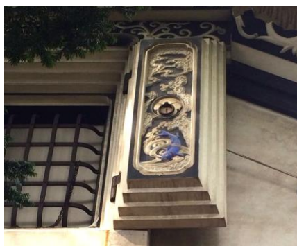
3-08 衣装蔵 東側外観 2階窓
