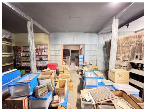
5-08 醸造蔵 内部1階 醸造タンク倉庫 西から
