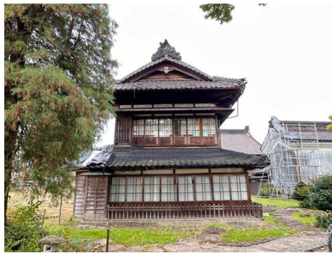
2-09 離れ座敷 南側外観
