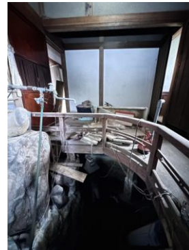
1-12 主屋 内部1階 便所
