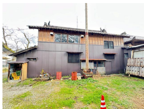
4-06 調整蔵 西側外観
