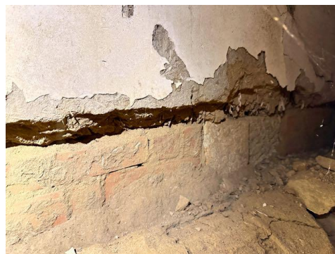
6-10 道具蔵 内部1階 切石基礎と間隙の煉瓦
