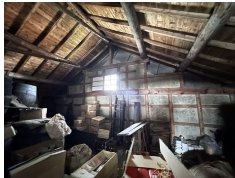
5-18 醸造蔵 内部2階 東から
