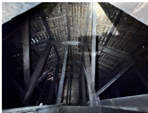
4-26 調整蔵 小屋裏
