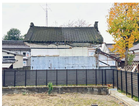
7-04 一号倉 北側外観
