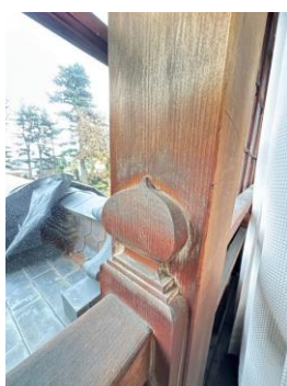
2-47 離れ座敷 内部2階 緑側の手すり付柱の擬宝珠
