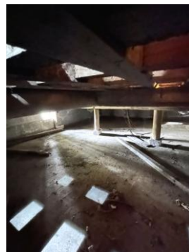
3-18 衣装蔵 内部 床下
