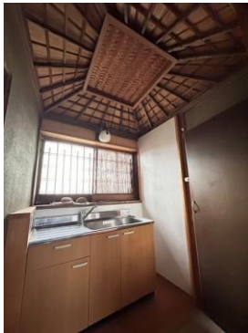
1-11 主屋 内部1階 洗面所
