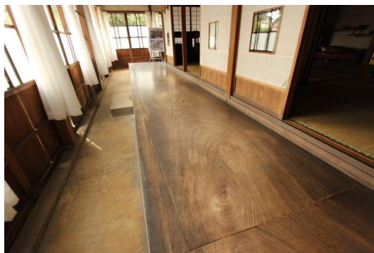
2-18 離れ座敷 内部1階 広縁 中央付近 北から
