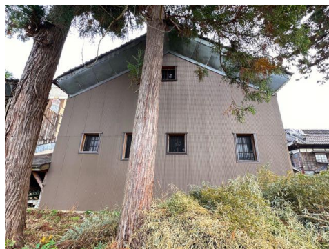
5-02 醸造蔵 西側外観
