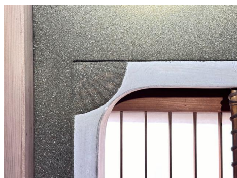
2-43 離れ座敷 内部2階 中の間 床脇
