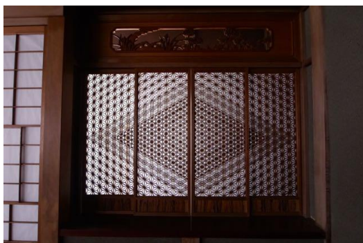
2-41 離れ座敷 内部2階 南の間 付書院の障子
