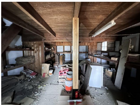
7-09 一号倉 1階内部 西から
