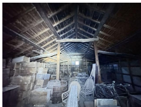
6-14 道具蔵 内部2階 南から
