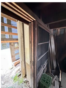
8-11 シチレン蔵 内部1階 出入口と3枚の建具
