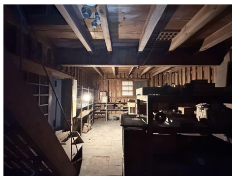
3-16 衣装蔵 内部1階 西から
