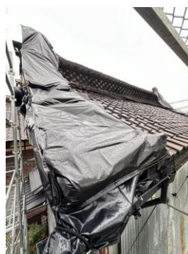
3-06 衣装蔵 屋根 南西から
