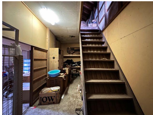
5-12 醸造蔵 内部1階 資材室 東から
