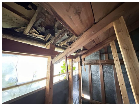
8-17 シチレン蔵 内部2階 南側登り梁部分
