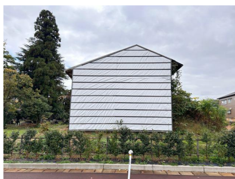
8-04 シチレン蔵 西側外観
