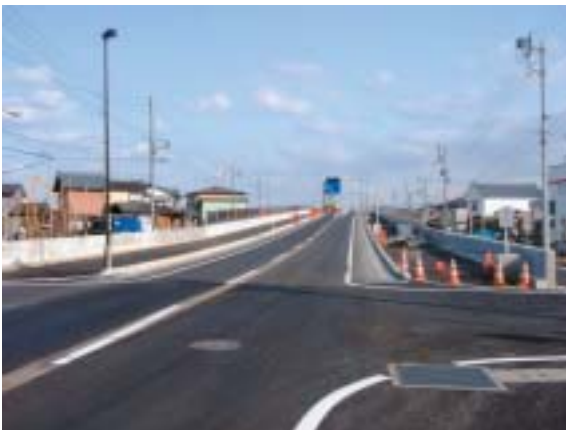
水害からの復興（道路整備）
