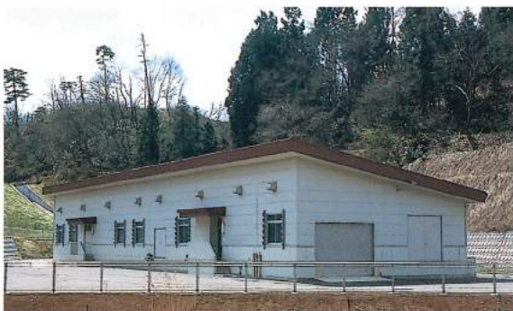
▲水処理施設棟
