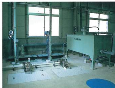
▲汚水計量分配槽
