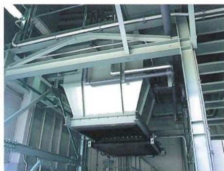
▲汚泥脱水機室
