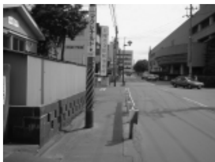
歩道幅員が狭い
