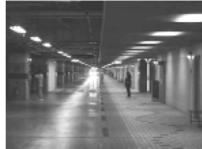
大手通り地下駐車場（通路）
