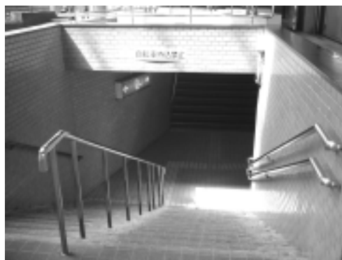
長岡駅地下通路（出入口部）
