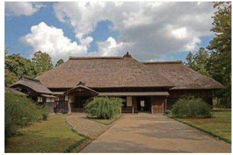
写真 2-1 旧長谷川家住宅
