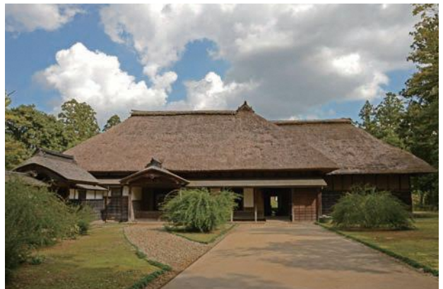
写真 8-5 旧長谷川家住宅
