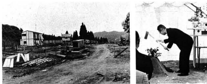
基礎工事が進んでいます。(6月20日撮影) ← 6月13日 起工式
