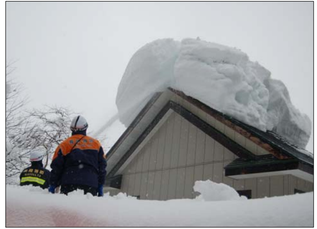
↑落雪式屋根の雪が落ちずに消防出動。(桂谷)雪が市道に落ちる可能性があるため消火栓から放水して緊急排雪。(1/26)
