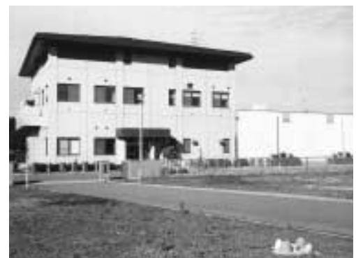
和島浄水センター
