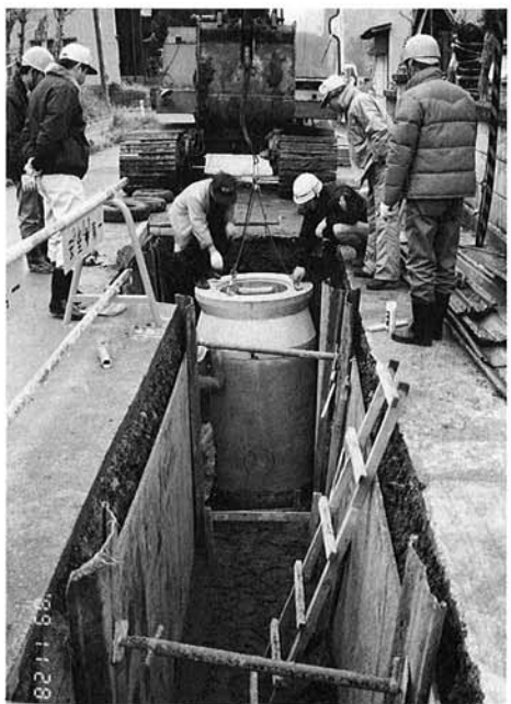
▲農業集落排水工事（両高）
