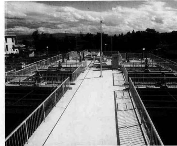
横流沈澱池 (浄水場内)
