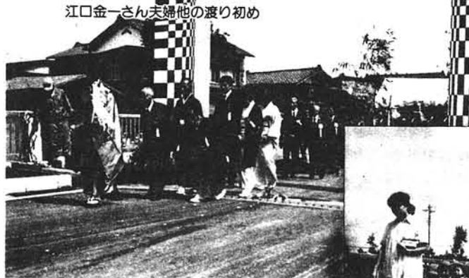
完成した平和橋
